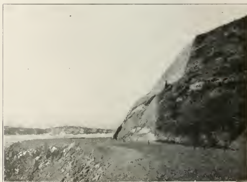
125-ft. Cut—"Daylighted"
