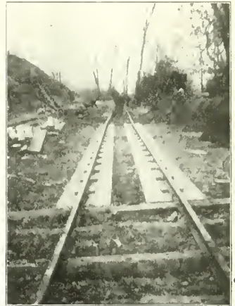
LONGITUDINAL CONCRETE STRINGERS.
