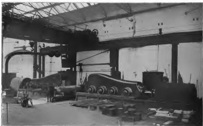
FIG. 23. DUPLEX HORIZONTAL STEAM HAMMER.
